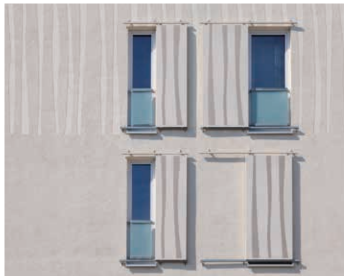
Florale Putzintarsien, die auf der Dämmschicht aufgebracht sind, spiegeln auf der Fassade wie auch auf den Schiebeläden eine variantenreiche Gestaltungssprache wider, die für ein ausgewogenes Verhältnis zwischen Vielfalt und Einheitlichkeit sorgen.
