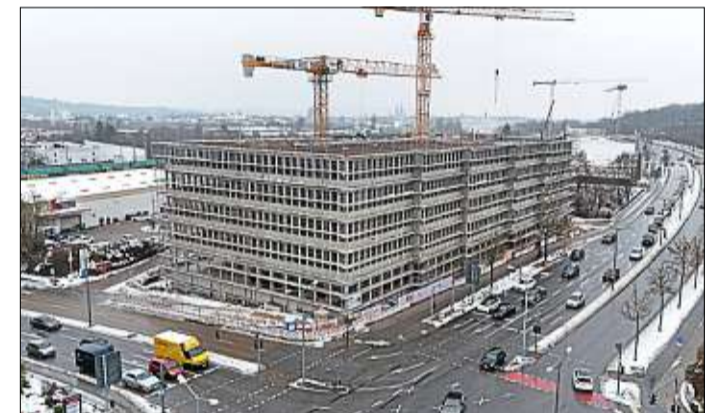
Der Rohbau des Lilienthalcenters wird noch vor Weihnachten fertig.
